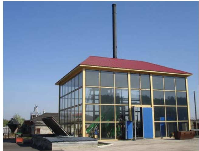
Рис. 2. Общий вид промышленной установки с топливным складом
